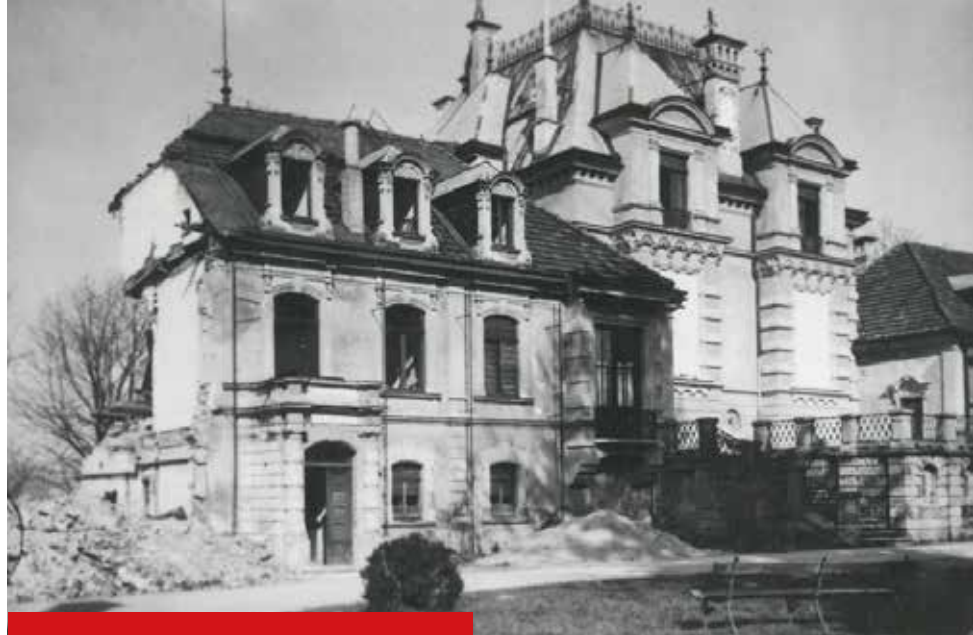
Der zerstörte Südflügel
