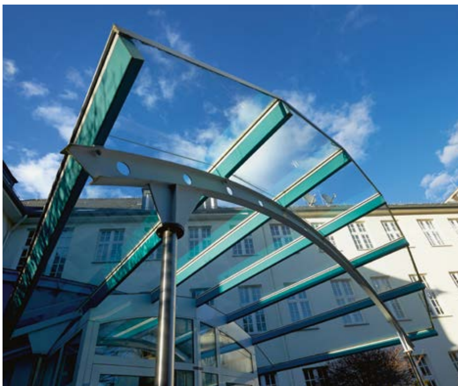
Blick in die Weite: der Eingang zur Hochschule
