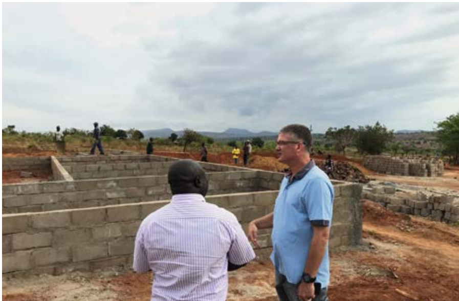
Br. Bert Meyer bespricht mit dem Bauleiter Bernard Nyang'wa den Fortgang der Arbeit am Pfarrhaus in Kaphatika.
