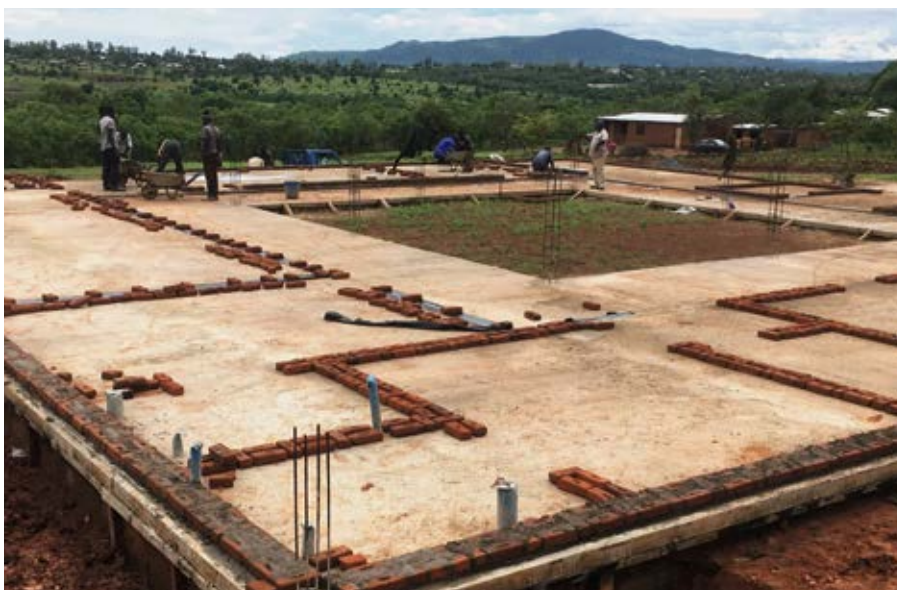
Blick auf die Baustelle im Januar 2019
